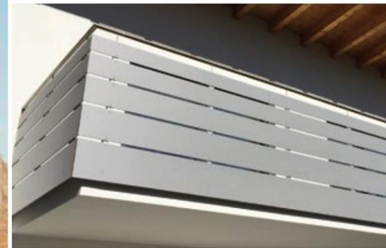
Exterior-Platten eignen sich speziell für witterungsausgesetzte Balkone und Terrassen
